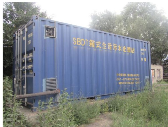
选煤厂生活污水处理站
